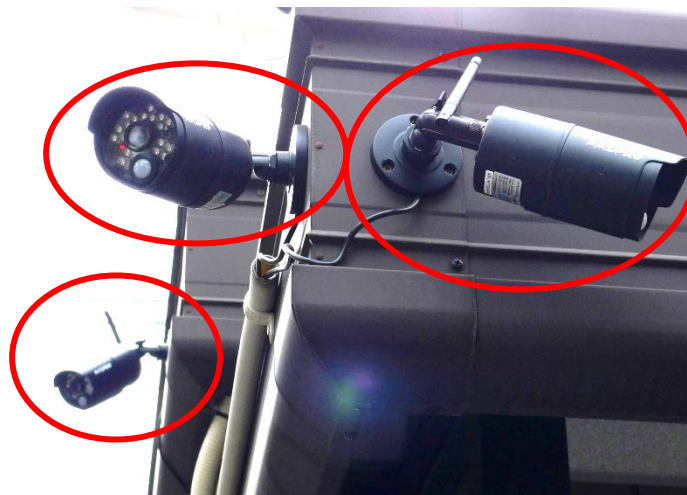
管理事務所に設置された防犯カメラ（石川町駅北口第二自転車駐車場）
